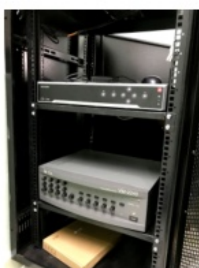
Lắp đặt hệ thống camera quan sát, hệ thống âm thanh
