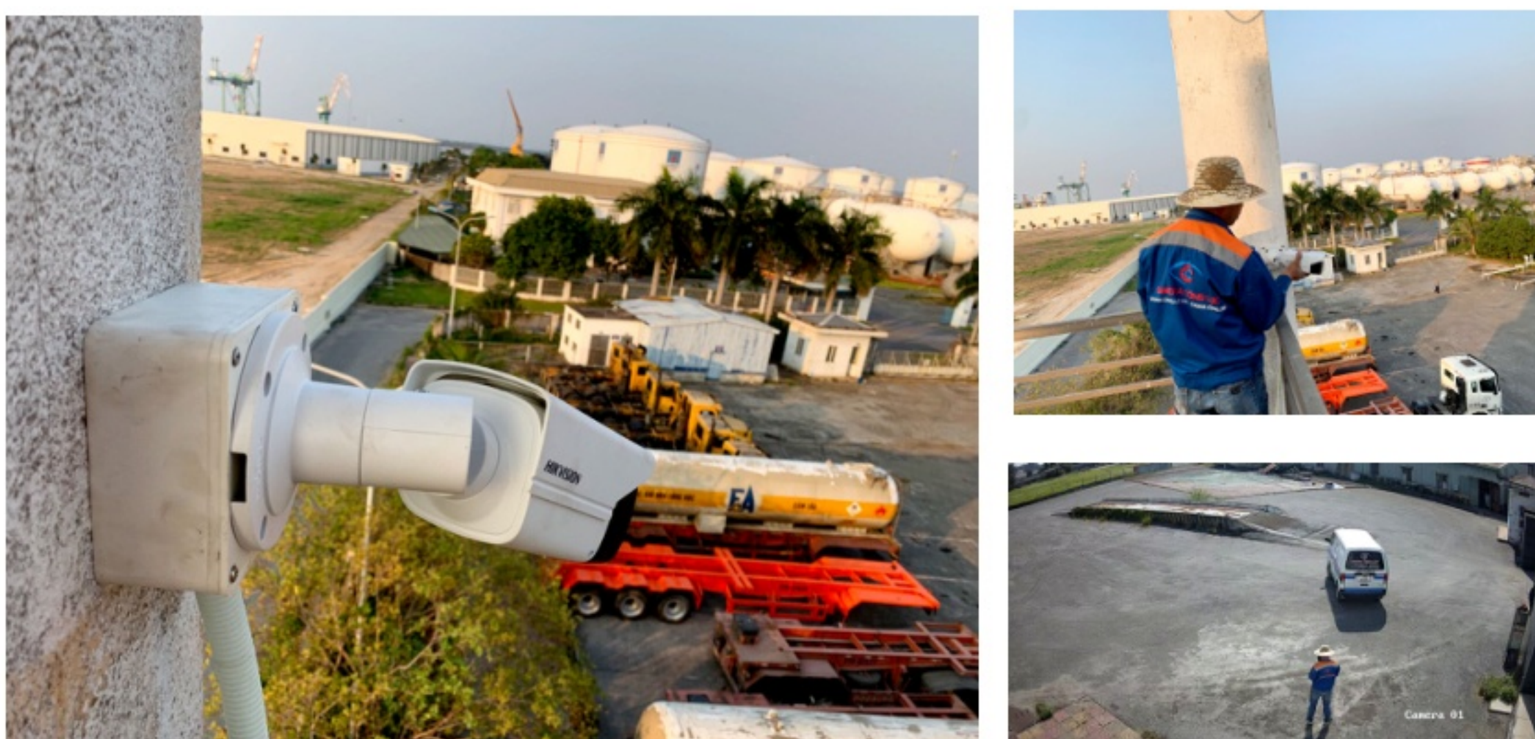
Lắp đặt hệ thống camera giám sát
