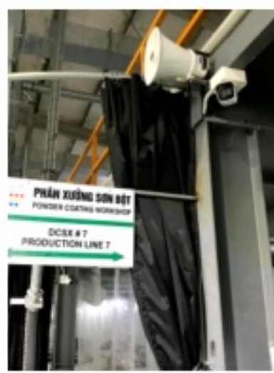
Lắp đặt hệ thống camera quan sát, hệ thống âm thanh
