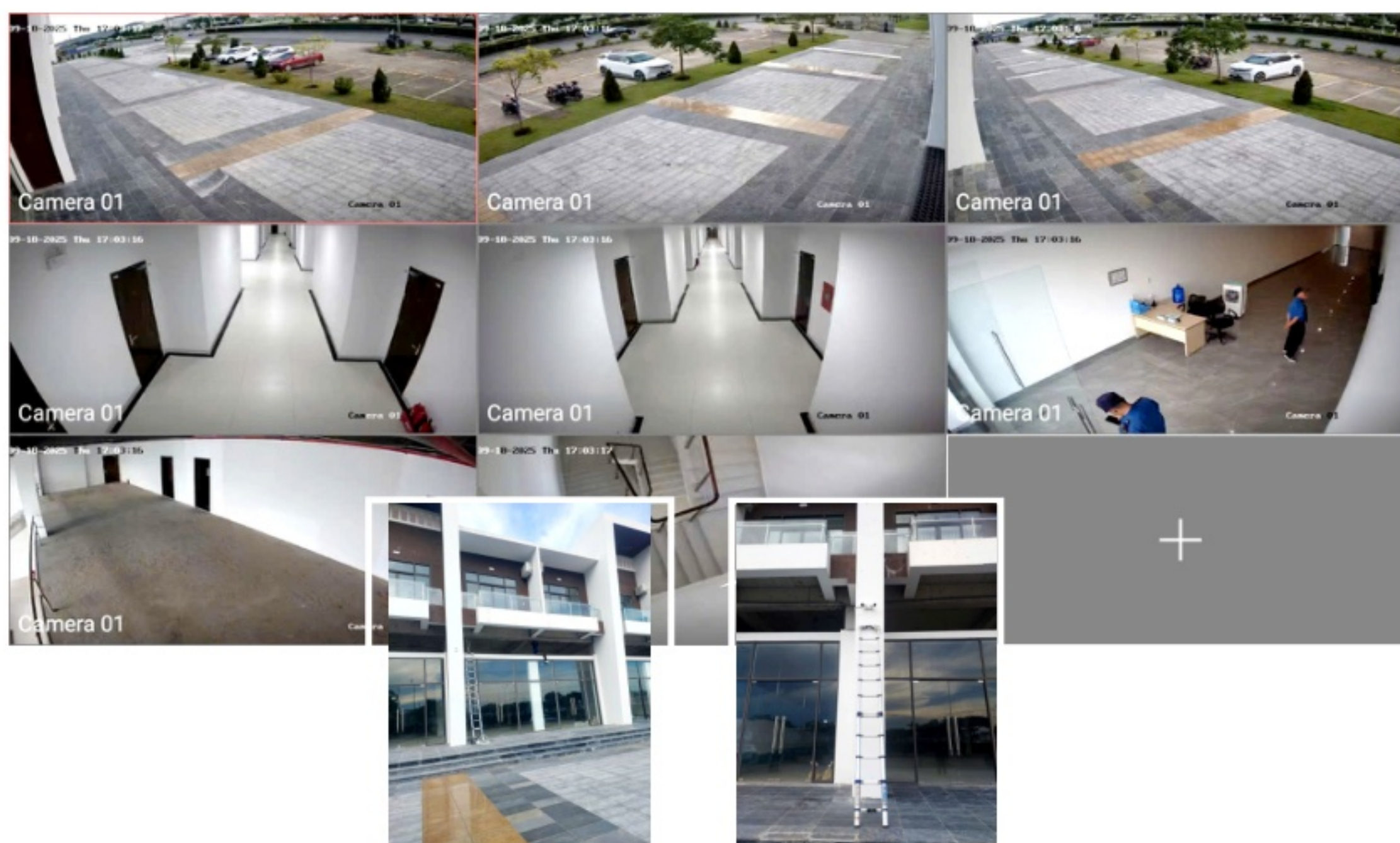
Lắp đặt hệ thống camera giám sát
